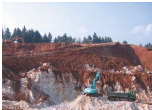
Izvajanje zemeljskih del v skali na zahodnem delu odlagališčne sklede, oktober 2005
