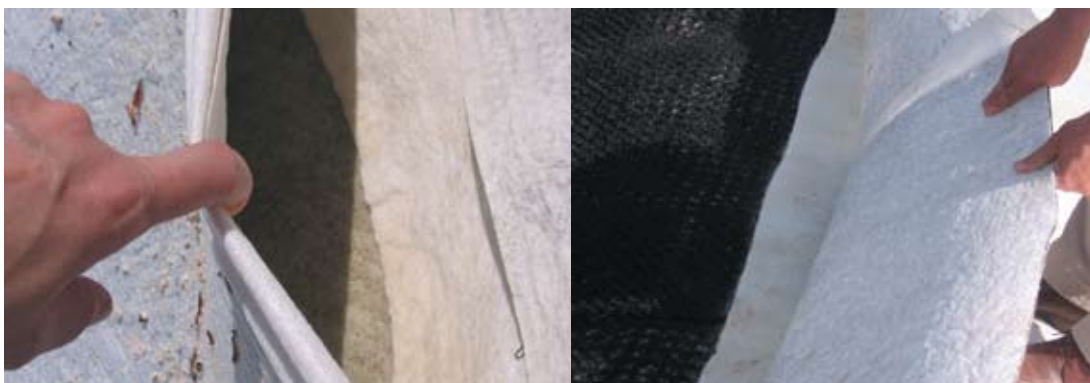
Preverjanje polaganja geotekstilov in geokompozitov, april 2006
