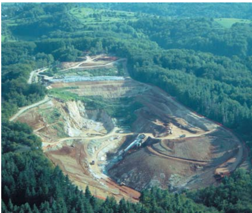
Dela pri izvedbi CeROD, I. faza v času intenzivnih zemeljskih del, oktober 2005
