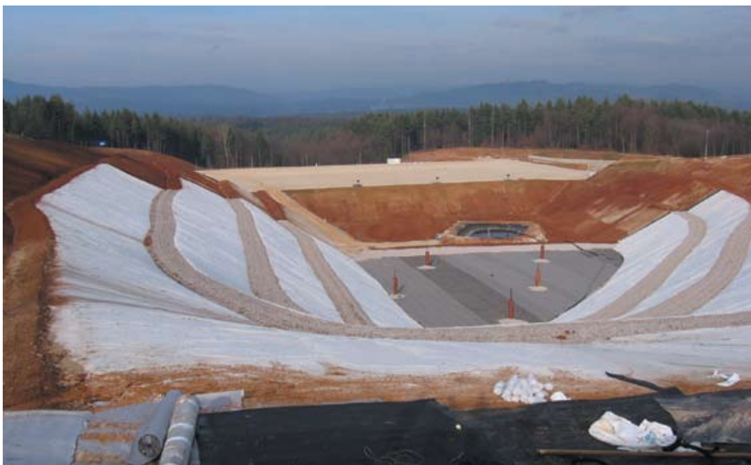
V dnu odlagališčne sklede so položeni geotekstilni in geokompozitni namesto slojev gline in gramoza, januar 2007
