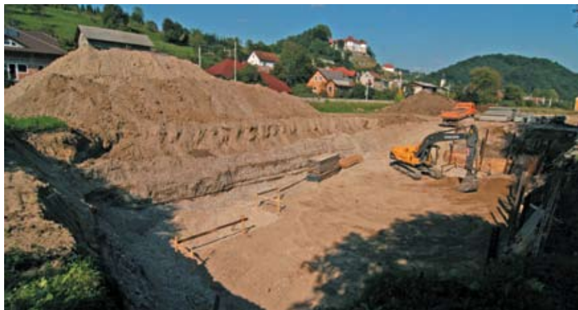
Izgradnja kanalizacije (foto Ljubo Motore)
