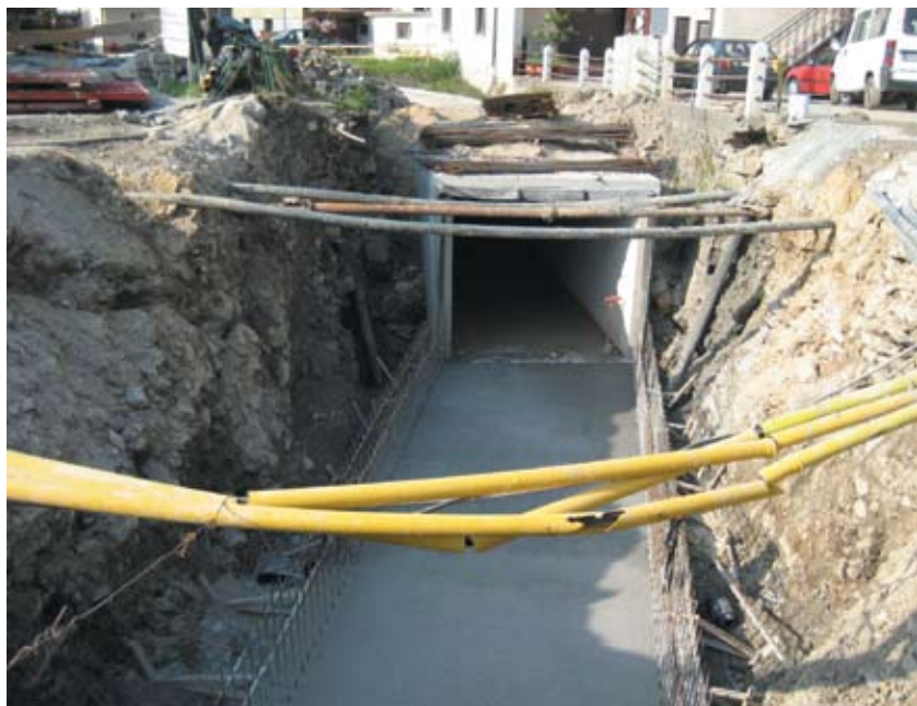
Kanaliziranje Drožanjskega in Florjanskega potoka (foto Uroš Krajnc)
