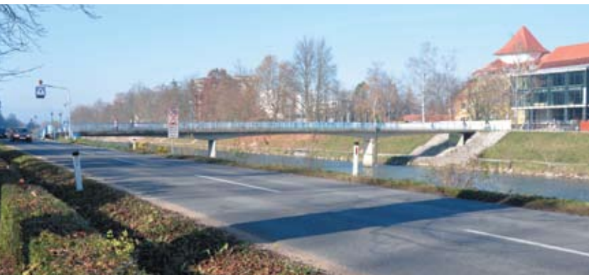
Slika 1: Splavarjeva brv in prometno nevarna točka priključka na Partizansko cesto
