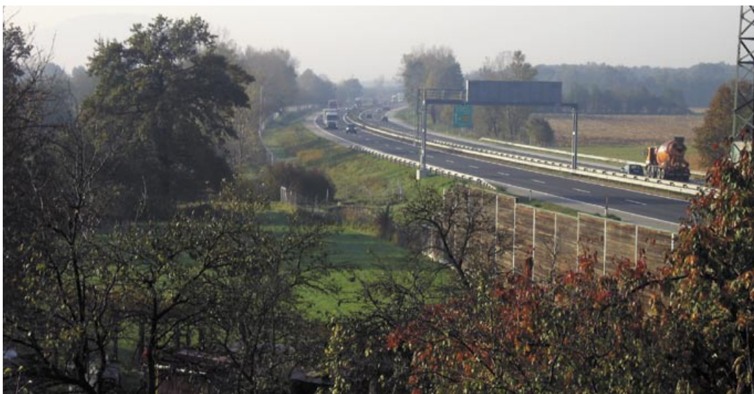
Čistilni objekt na štajerski avtocesti pri Hotinji vasi (fotografija Petra Kralj)
