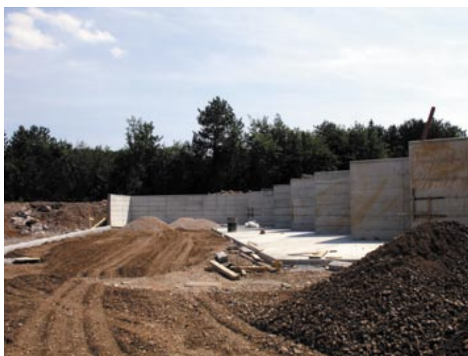
Zbirni center v izgradnji (posneto junija 2005)
