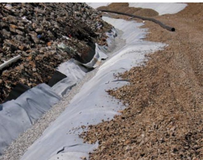
Urejanje odlagalnega polja z drenažo za odvod izcednih vod
