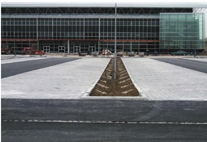
Izvedeno parkirišče, poglobljeni pas še ni zatravljen
