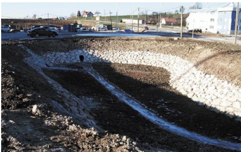
Zemeljski zadrževalni bazen med gradnjo
