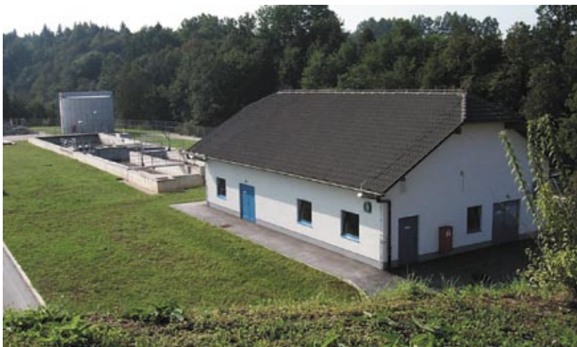
CČN Črnomelj (5.000 PE)
