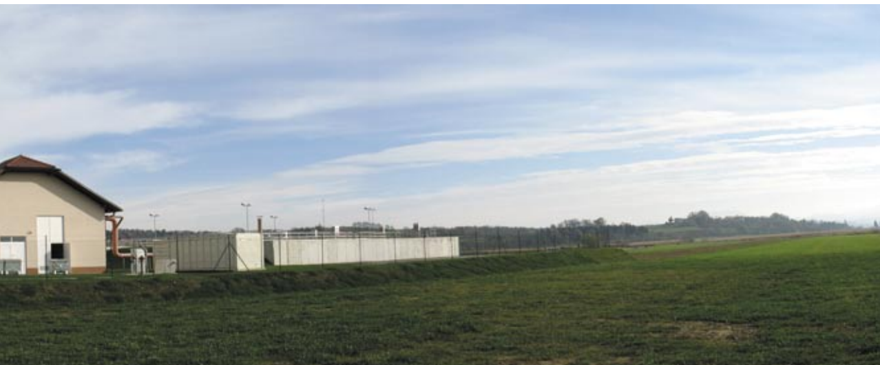
CČN Slovenska Bistrica (15.000 PE) sekvenčna naprava z aerobno stabilizacijo blata. Naprava je v obratovanju in dosega večji učinek čiščenja od projektiranega.
