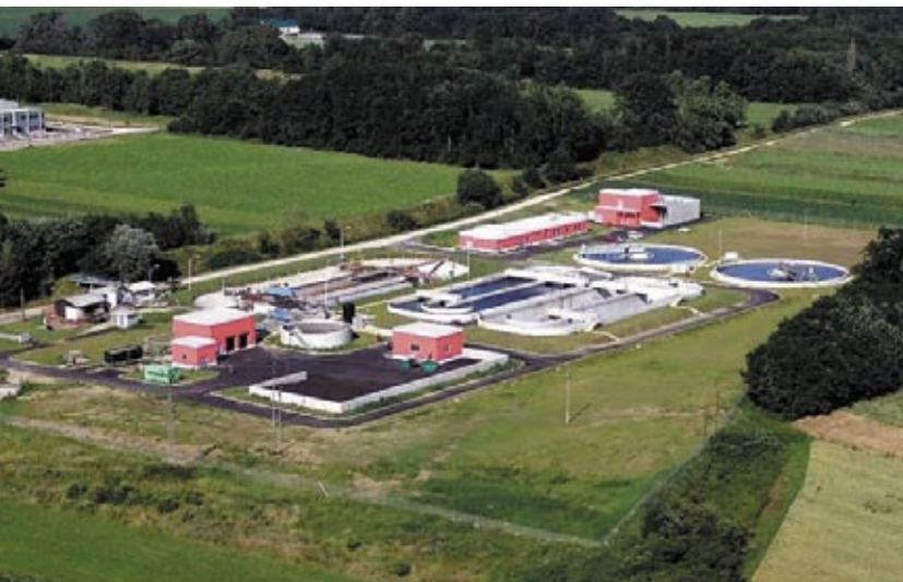
CČN Murska Sobota (42.000 PE) klasična pretočna naprava z možnostjo simultane nitri/denitrifikacije ali intermitenčnega obratovanja in aerobno stabilizacijo blata. Naprava je v obratovanju in kljub preobremenitvi (predčiščenje mlekarne še ni zgrajeno) dosega precej večji učinek čiščenja od projektiranega.
