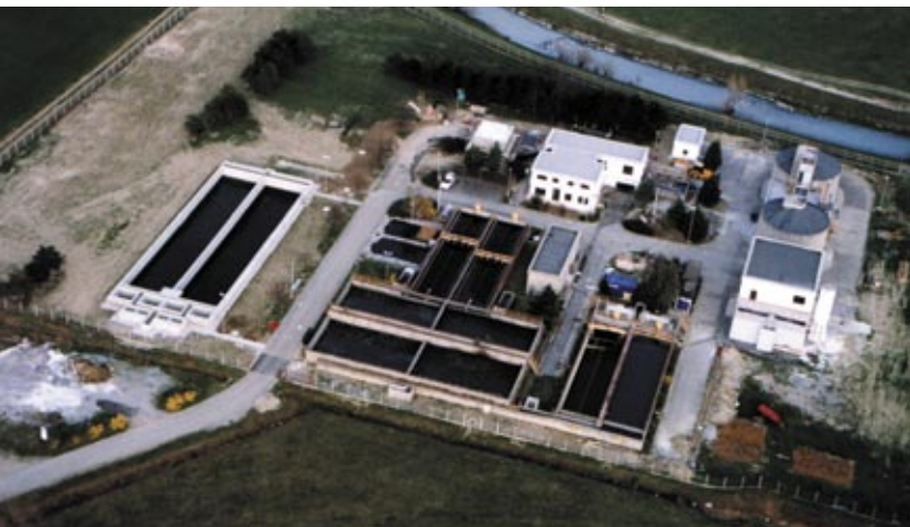
CČN Ajdovščina (42.500 PE) obstoječa mehansko-biološka naprava, projektirana za čiščenje ogljikovih spojin se je rekonstruirala, tako da se je povečala zmogljivost čiščenja in uredilo čiščenje dušika. Naprava obratuje kot klasična pretočna naprava s predhodno denitrifikacijo in anaerobno stabilizacijo blata v obstoječih gniliščih. Naprava obratuje in dosega večji učinek čiščenja od projektiranega.
