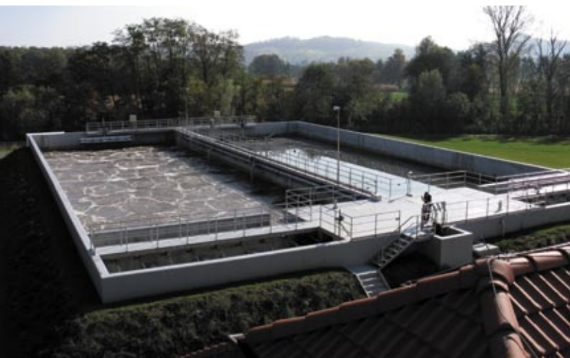
CČN Ljutomer (23.000 PE) sekvenčna naprava z aerobno stabilizacijo blata. Naprava je v poskusnem obratovanju in je že dosegla večji učinek čiščenja od projektiranega.
