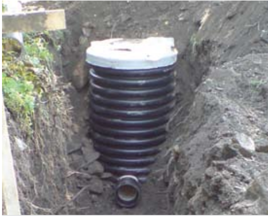
Izvedba kanala B
