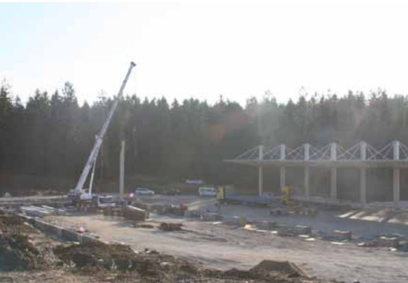
Slika 1: pogled na izvajanje gradbenih del na Mislinjski Dobravi
