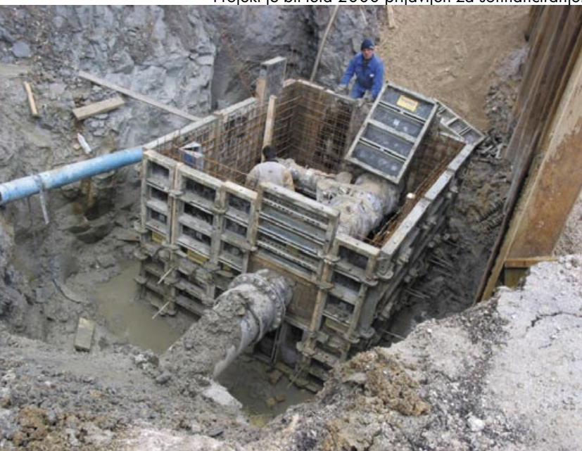
Izgradnja vodovodnega cevodovoda Šoštanj-Pesje (foto Uroš Krajnc)
