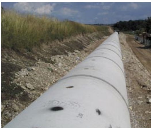
Glavni zbiralnik do črpališča Melje do čistilne naprave v gradnji, avtor slike Uroš Krajnc
