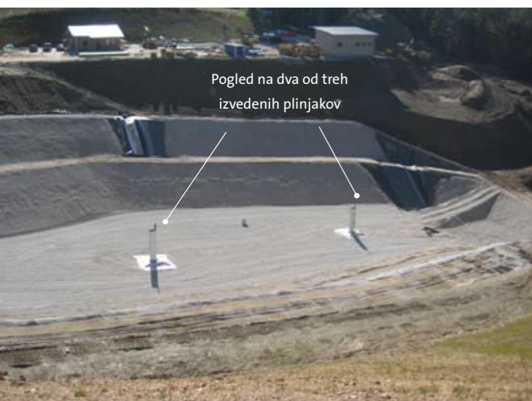
Slika 3: Pogled na izvedena plinjaka
