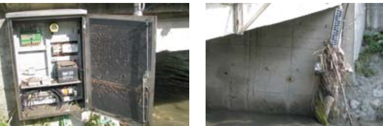
Slika 1: Samodejna vodomerna postaja Medija Zagorje (ARSO mreža) po povodnji septembra 2010
